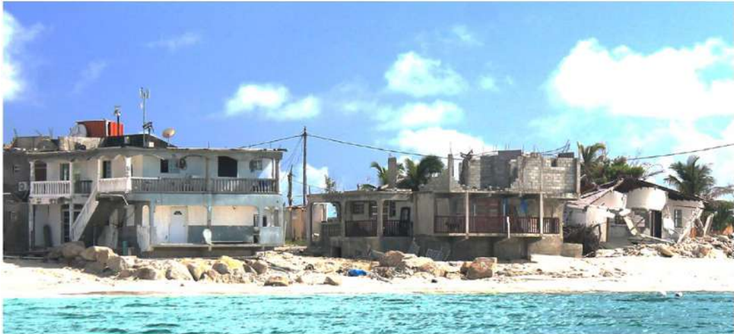
Figure 5.22 Impact du cyclone Irma sur les habitations de Baie Nettlé, mai 2018 (cliché © Louis Portier, Réf. /6/).
