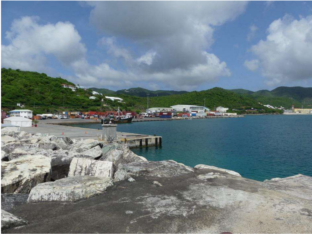
Photographie 1 : Vue du Port de commerce de Saint Martin.
