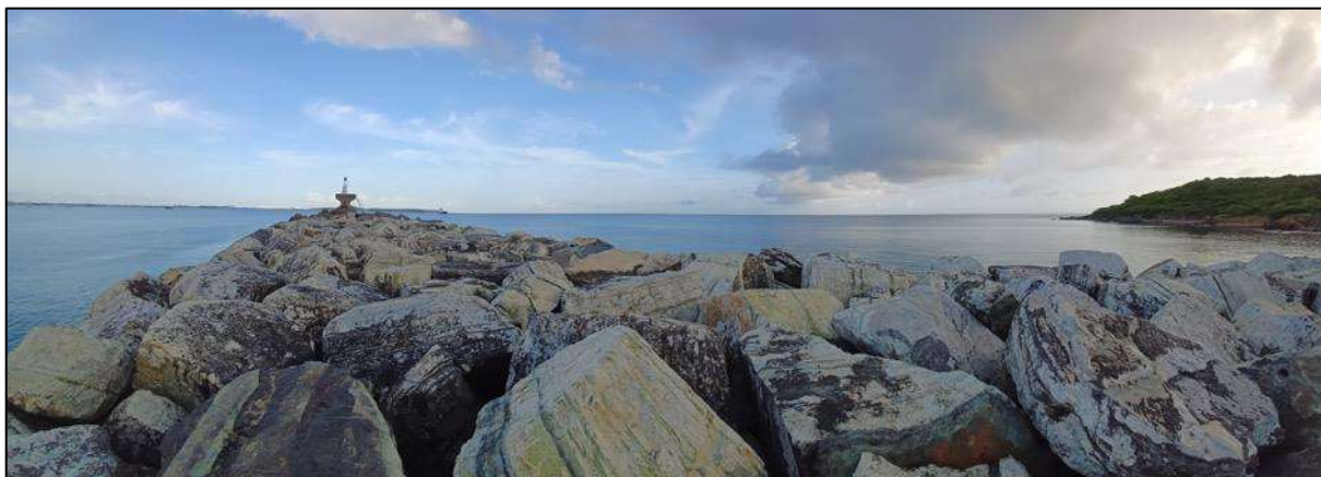
Photographie 2 : Enrochement de la digue nord du site
