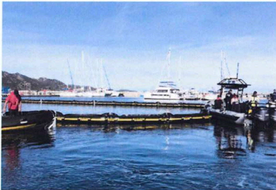
Figure 19 : Déploiement d'un barrage antipollution à Saint-Florent (Source web)
