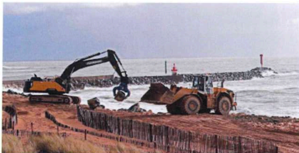
Figure 17 : Les engins de TP sont de gros émetteurs (Source web)
