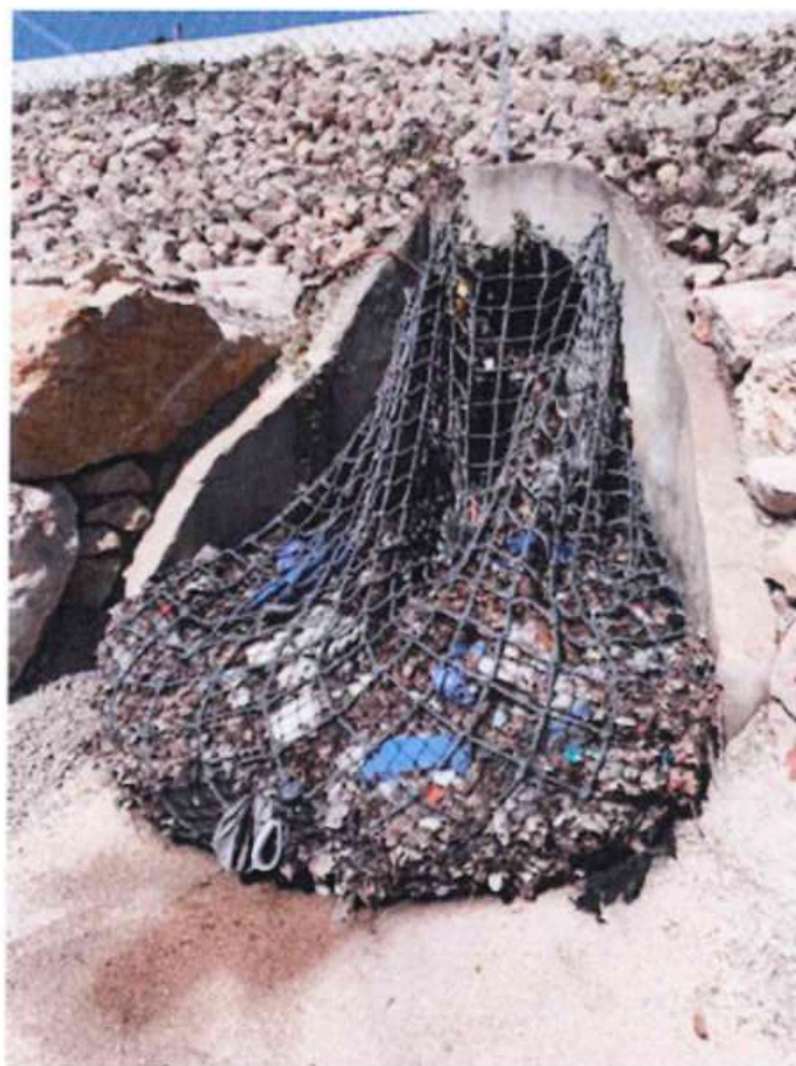
Figure 39 : Exemple de filet collecteur de macrodéchets (Source Pollustock, 2024)
