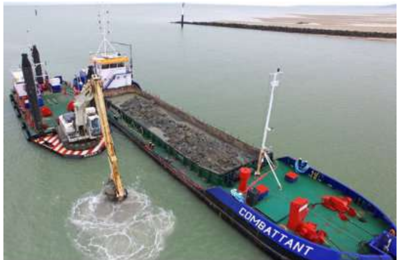
Figure 5 : Exemple d'un dragage mécanique (source Océlian - VCMF)
