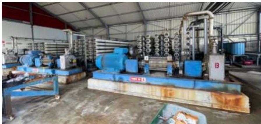
Figure 4 : Les 3 unités d'Osmose inverse (source Gaïa, 2020)
